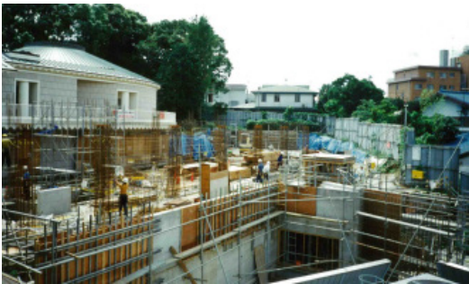
増改築工事中の展示館と新館地下部分
